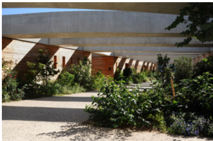
Photo 2 Pied de bâtiment - Ecole Internationale de Manosque Région PACA - Crédit photo Léon Grosse
