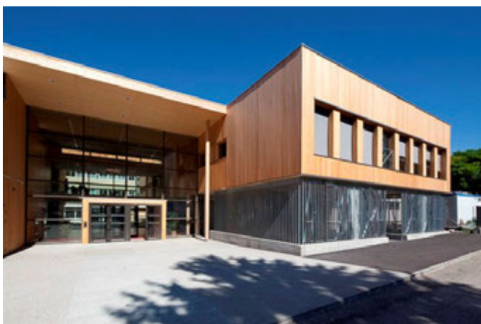
Photo 1 Un abri à vélos fonctionnel - Lycée David Neel Région PACA
